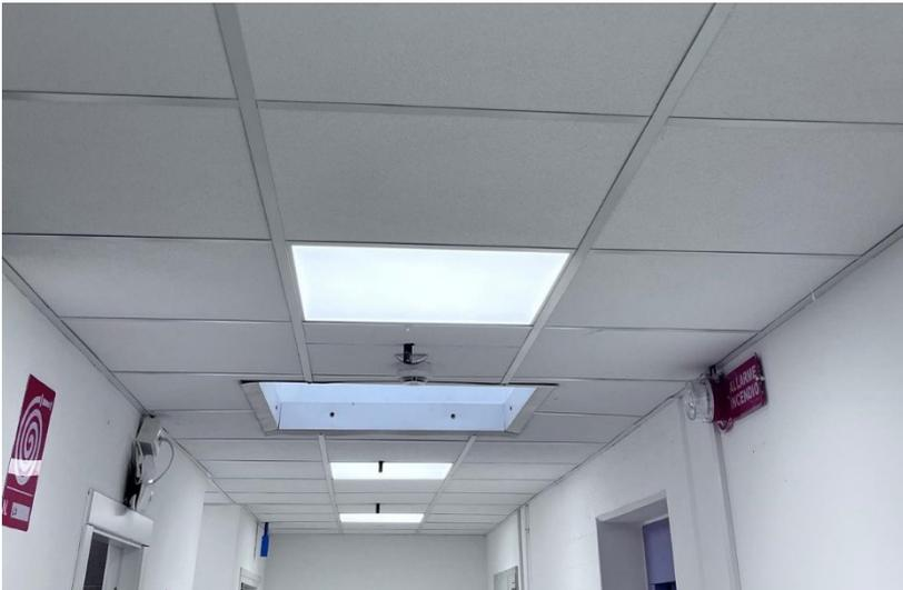
Altro intervento di risparmio energetico diffuso è stato il Relamping dei corpi illuminanti interni di diversi edifici, con la sostituzione a LED e l'implementazione di sistemi DALI per la gestione intelligente del livello di illuminamento indoor, con ubicazione e stato di avanzamento interventi come da tabella 3
