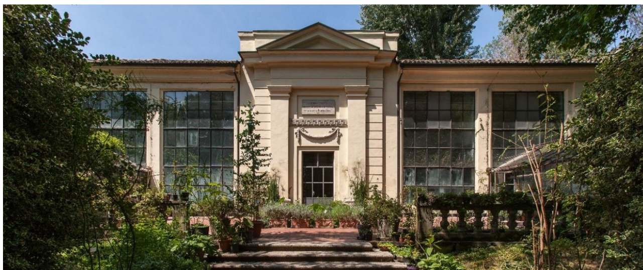
Serre Ferdinandee – Stato attuale fronte sud
