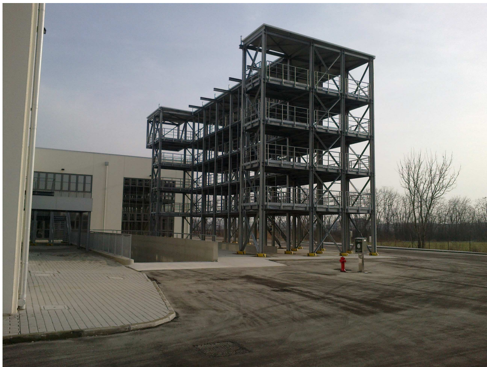
8 – Torre di prova per ponteggi
