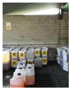
Figura 8 – Esempio stoccaggio rifiuti pericolosi (B)
