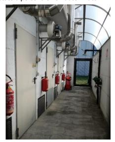
Figura 6 – Esempio posizionamento attrezzature antincendio e aspirazioni
