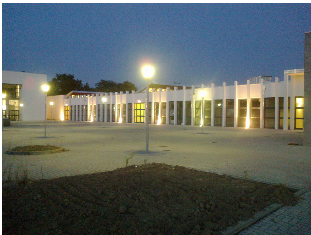
Il piazzale di accesso del Polo Didattico
