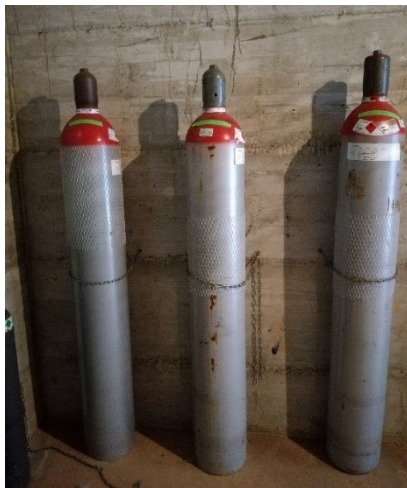
Figura 9 – Esempio di stoccaggio (la catena deve essere sostituita con cinghia in materiale isolante)
